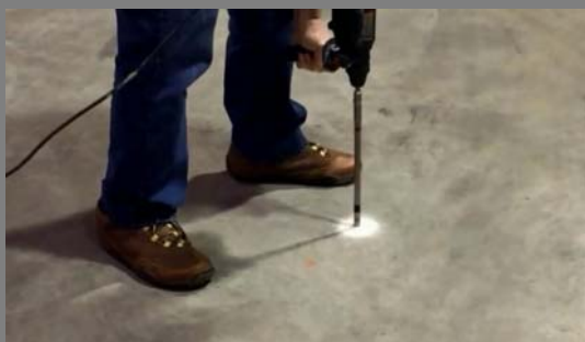
路面铺设磁钉
